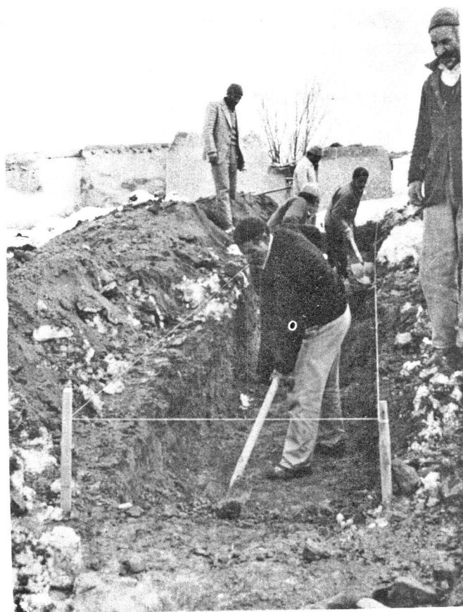
تصویر ۲۱- آغاز خاکبرداری در مجاورت برج- ۶ در جبهه غربی ارگ
